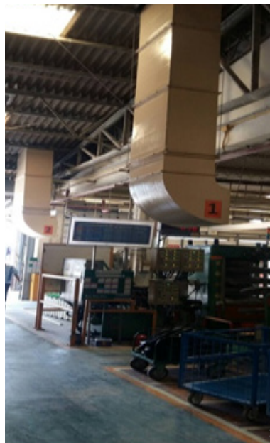
ติดตั้งระบบระบายอากาศเพื่อระบายความร้อน
